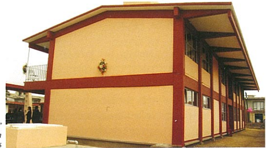
Escuela: Primaria "Pedro Morales" Municipio: Axocomanitla Apoyo: Demolición y Construcción de Aulas
